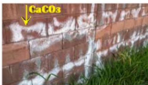
Figura 10.7 – Eflorescências em alvenarias
