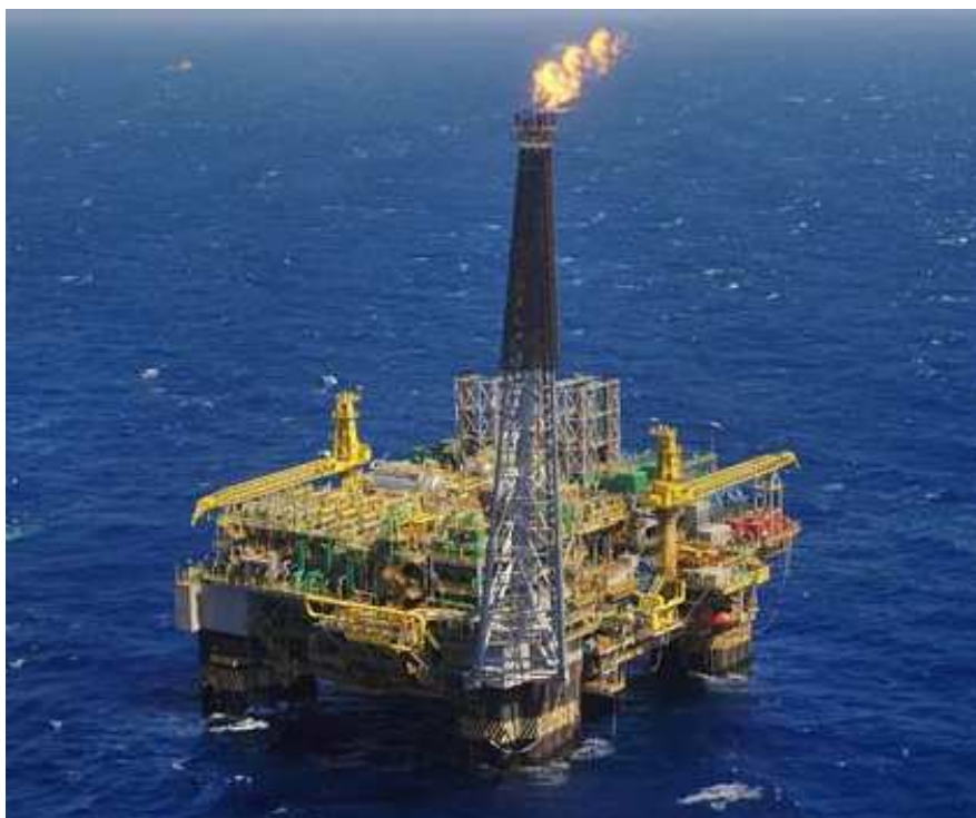
Figura 1.2 – Plataforma P-52 em operação na Bacia de Campos - Fonte: http://www.petrobras.com.br
