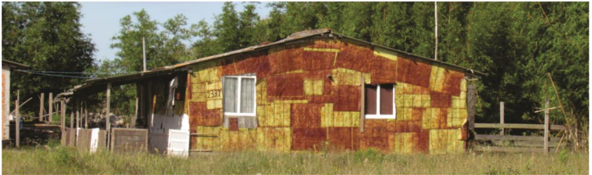
Figura 6 – No alto: A paisagem da Ilha dos Marinheiros com vista à Laguna dos Patos. Abaixo: Destaque para uma casa forrada com cunhetes. Fonte: Acervo Karen Melo da Silva.
