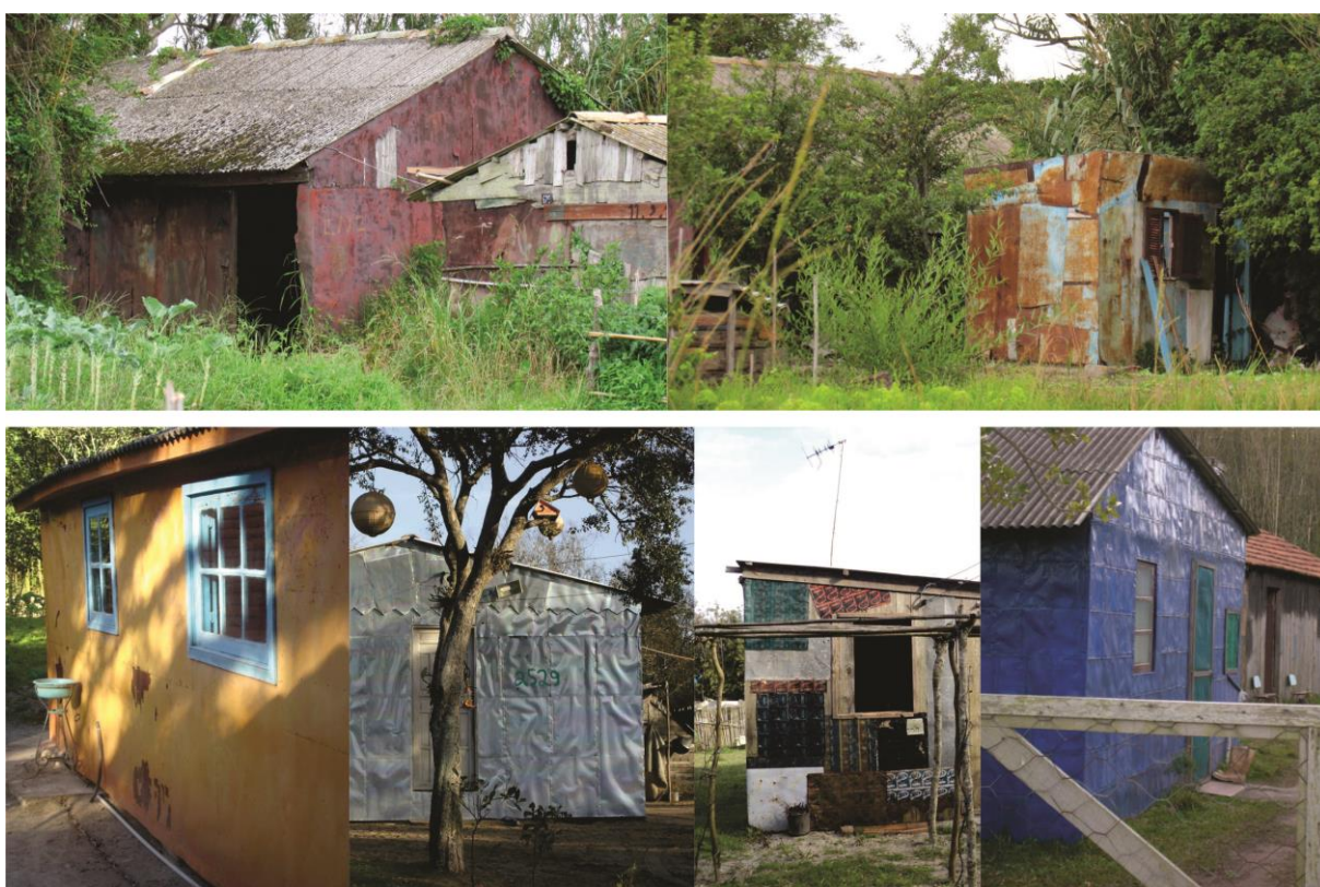
Figura 05 – Casa de madeira forrada com lata. Fonte: Acervo Karen Melo da Silva.
