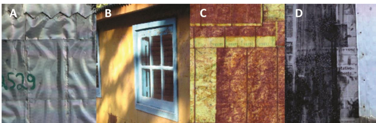
Figura 4 – Tipos de latas utilizadas para revestir edificações de madeira: A) Chapa lisa sem pintura; B) Chapa lisa pintada. C) Chapa com estampa em offset ; D) Chapa com offset .
