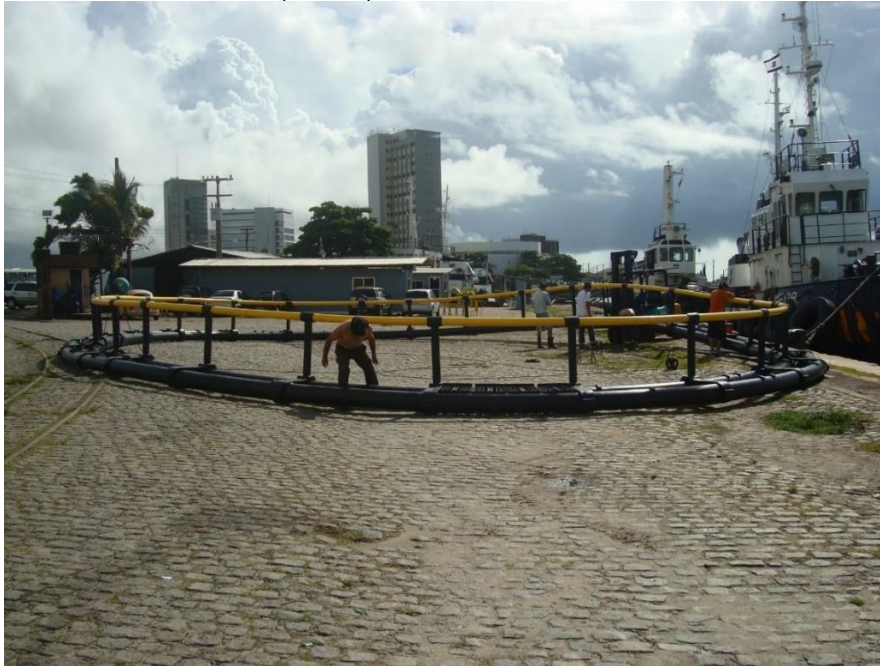
Figura 3.8 – Montagem final da estrutura flutuante de uma gaiola circular de polietileno de alta densidade (PEAD) na base em terra
