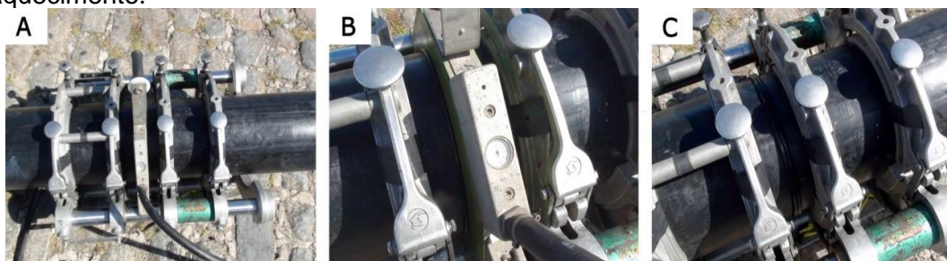
Figura 3.7 – Processo de solda por termofusão utilizado na montagem das gaiolas de polietileno de alta densidade (PEAD): (A) chassi hidráulico utilizado para alinhar e pressionar os dois tubos sobre um disco metálico aquecido, (B) derretimento das extremidades dos tubos de polietileno de alta densidade – PEAD, e (C) união dos tubos de PEAD aquecidos após a retirada do disco de aquecimento.
