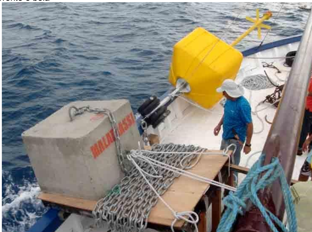
Figura 3.5 – Rampa de madeira adaptada no convés de embarcação e utilizada para o lançamento do sistema de sinalização composto por poita de concreto, corrente e boia
